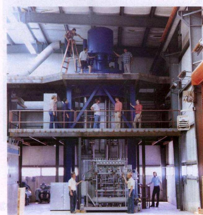
(c) Tevatron中液氮系統可以每小時生產4,600公升，維持超導磁體操作（美國Fermilab Visual Media Services提供）
